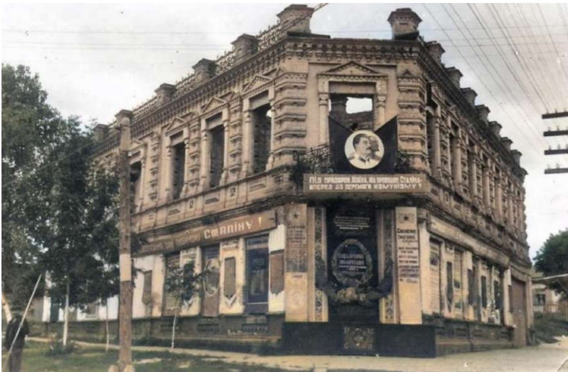
Рисунок В.4 – Фото кін. 1940-х рр. [11]. Праворуч колишньої аптеки Вержицького на місці раніше прибудованої 1-поверхової будівлі пуста ділянка, будівлю втрачено. Решта 1-поверхової забудови залишилася.
